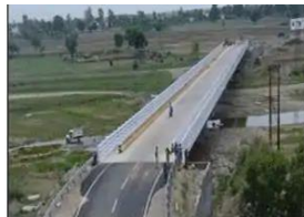
TARNAH-I BRIDGE (160 m)
