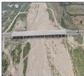
GHODAWALA BRIDGE(151 m)
